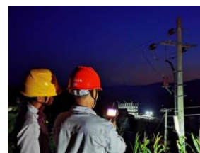
工业测温、电力点检
